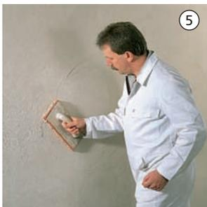
⑤ Anschließend muss er mit der Schwammscheibe von Hand oder maschinell durchgeschwämmt werden. Hierzu ist die Putzfläche vorher gut anzunässen.
