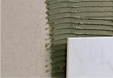
Dient der Gipsputz als Untergrund für keramische Beläge, muss er in einer Mindestdicke von 10 mm aufgebracht werden und darf nur sauber ausgezogen werden. Damit wird eine festere und rauere Oberflächenstruktur erzielt. Der Gipsputz darf weder gefilzt noch geglättet werden.
