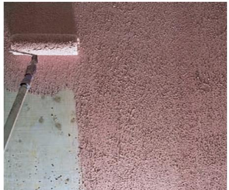
Auftrag der Haftbrücke Rikombi Kontakt. (Wichtig: Vor dem Auftragen umrühren, damit das Schwebekorn verteilt und damit die geforderte Struktur erreicht wird.
