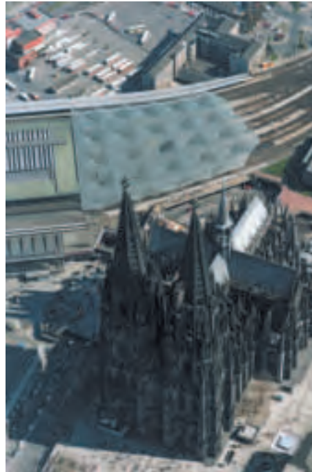
Vorhallendach, Köln Hauptbahnhof
