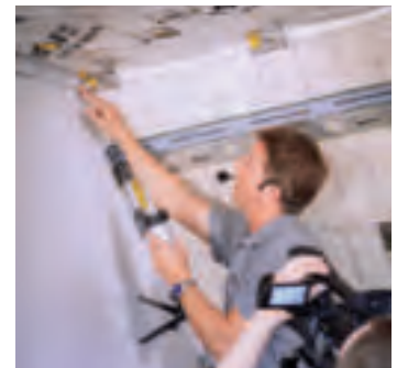
ISOVER Praxistrainer Peter Bensch zeigt in einer Sendung des Web-TV's ISOVER live den Anschluss der Vario® Klimamembran an eine Giebelwand.
