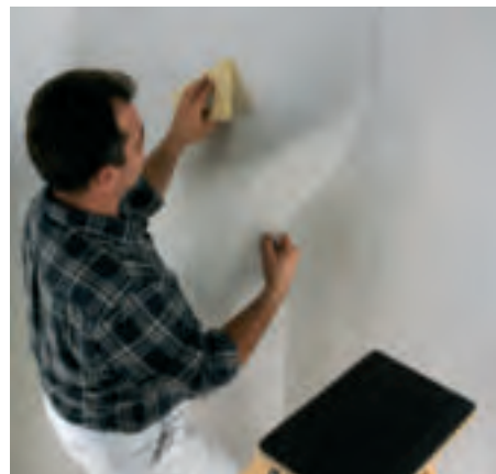
2. Anbringen des Wandbelages: mit einer Tapezierspachtel blasenfrei andrücken, Überlänge mit Cuttermesser abschneiden.
