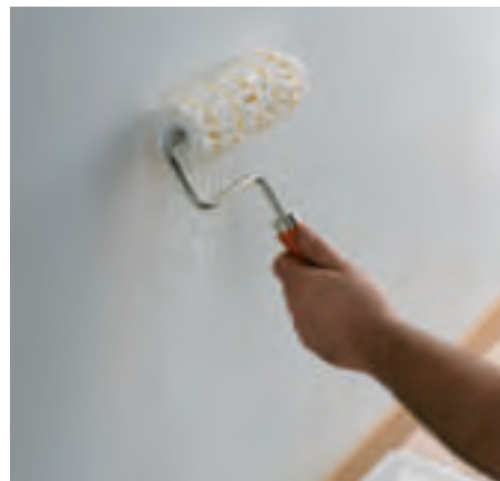
1. Gleichmäßiges Auftragen des Vinylklebers mittels Lammfellroller.
