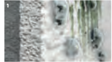
1: Bei herkömmlichen hydrophoben Putzen bleibt die Fassadenoberfläche lange feucht. Tauwasser und Regen sammeln sich in kleinen Putztaschen und verdunsten dort nur langsam.
