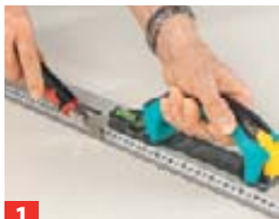
1 Der Zuschnitt erfolgt wie üblich per Cutter durch Anritzen und ...
