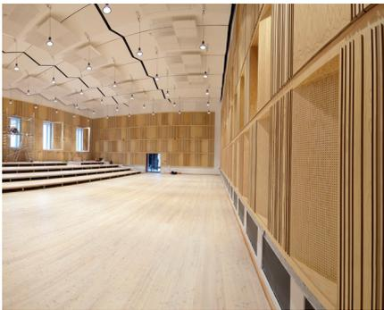
Die Herausforderung bei diesem Projekt bestand im Umbau des Orchesterprobensaaals im Niedersächsischen Staatstheater mit seiner Deckenhöhe von 9 Metern. Die Hauptforderung war die Verbesserung der Raumakustik auf eine Geräuschemission von maximal 25 dB. Dies wurde mit Hilfe eines 'Raum im Raum' Konzepts erreicht.
