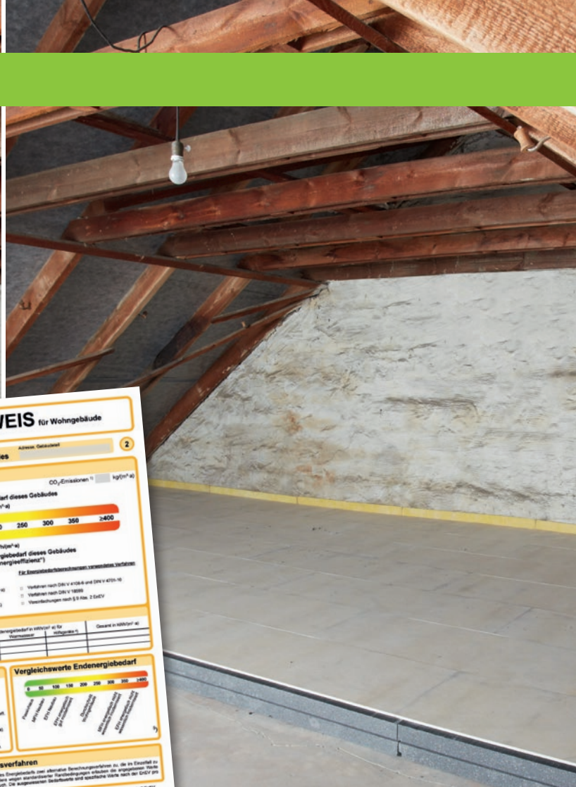
Sanierter Dachboden in Bearbeitung
