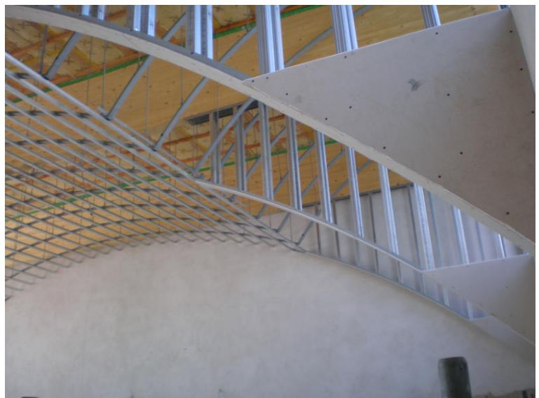
Bild 2: Anschlussituation der Decke Gymnasium Atrium, Hagenow Ausbau eines Schulgebäudes im Rahmen einer Sanierung mit einer gewölbten abgehängten Decke.
