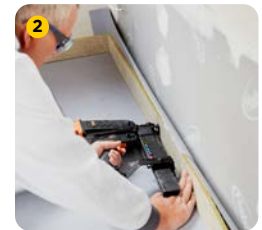
Randdämmstreifen verlegen
