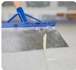
Überschüssigen erhärteten Kleber abstoßen
