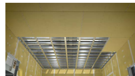
Montage der Tragprofile und der unterseitigen Deckenbekleidung
