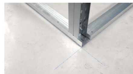
Stellung der UA-Profile mit Verankerung am Boden
