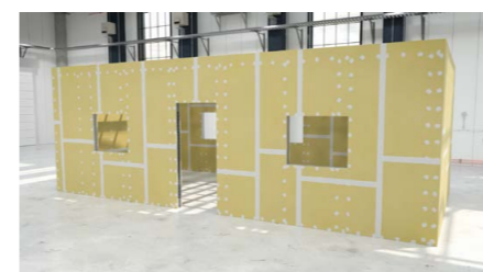
Abschließende Spachtelarbeiten, Kantenschutz und ergänzende Arbeiten (z. B. Boden im RigiRaum)
