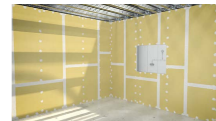
Montage der innerseitigen Bekleidung
