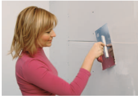
Spachtelmasse in die Fuge einbringen
