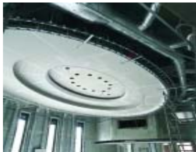
Lutz Werner Trockenbau GmbH, Dresden Japanische Botschaft Berlin Architekt: Ryohei Amemiya und HPP Bauherr: Landesvertretung von Japan
