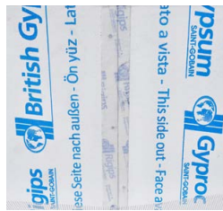
Rigips Glasroc X-Platten, Stoß mit Fugenband abgeklebt
